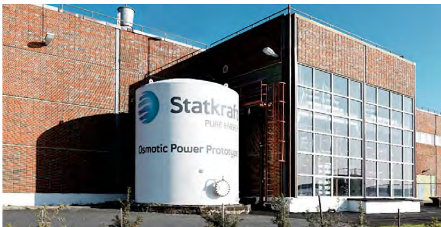
Электроэнергия на осмотической электростанции производится просто за счет смешивания пресной и морской воды.
